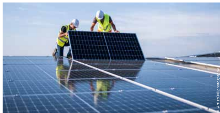
Zwei Ingenieure installieren eine Solaranlage auf einem Dach.
