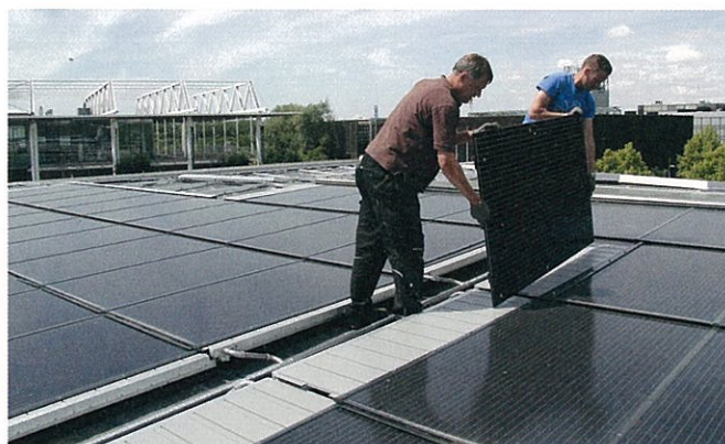
Montage der Indach-PVT-Anlage auf dem Dänischen Pavillon in Hannover.
