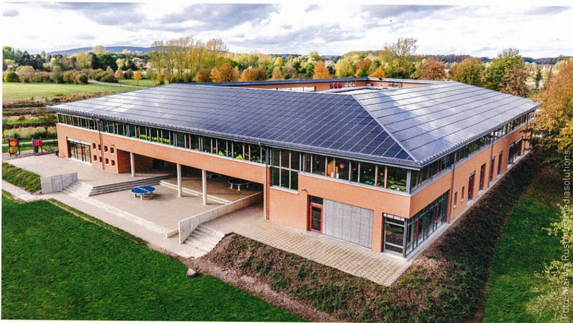
Neubau der Grundschule Gronau (Leine) als Plusenergie-Schule mit gebäudeintegrierter Photovoltaikanlage.
