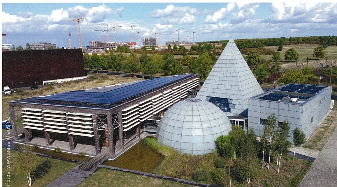
Dänischer Expo-Pavillon in Hannover mit gebäudeintegrierter PVT-Anlage auf dem Hauptgebäude.
