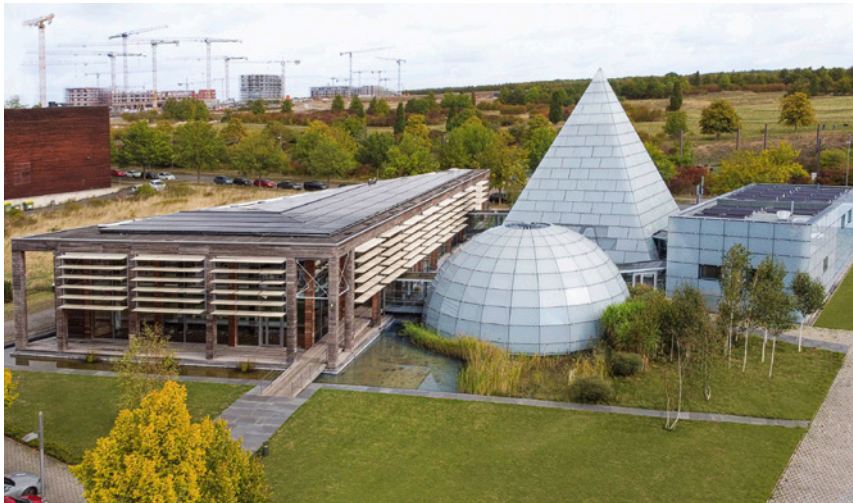
Abb. 02: Luftbild Dänischer Pavillon mit PVT-Anlage [Foto: Architektur- und TGA-Planungsbüro Grobe]
